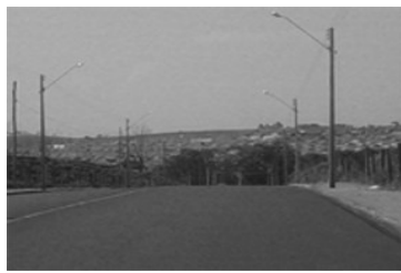
Foto 3: Estrada de acesso ao loteamento Maré Mansa. Paisagem modificada pelo homem gerando riscos ambientais. Foto: Hirao, 2005.
