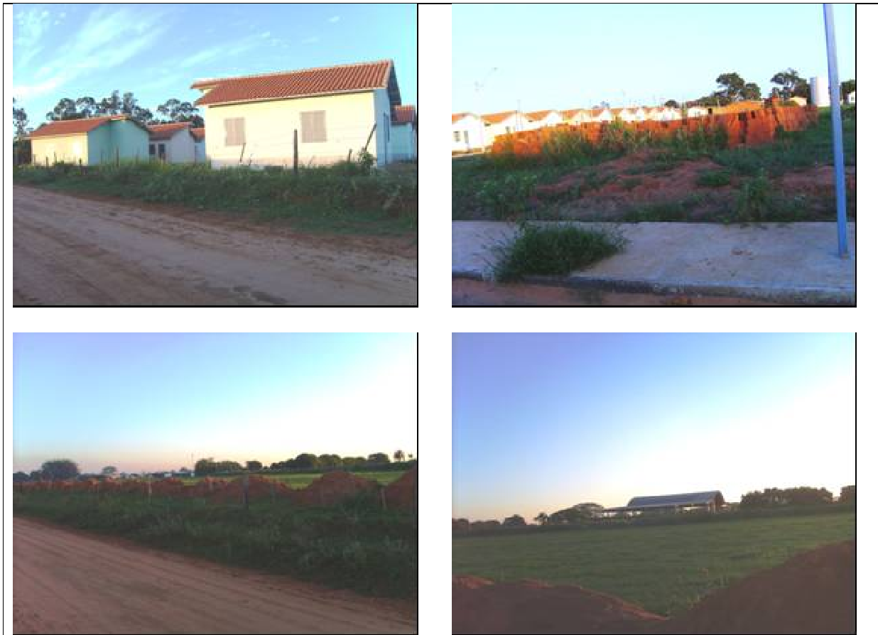
Figura 3: Loteamento em fase final de construção ao lado do aeroporto municipal
