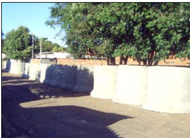
Foto 5: Obras de canalização na rua Goiás.
