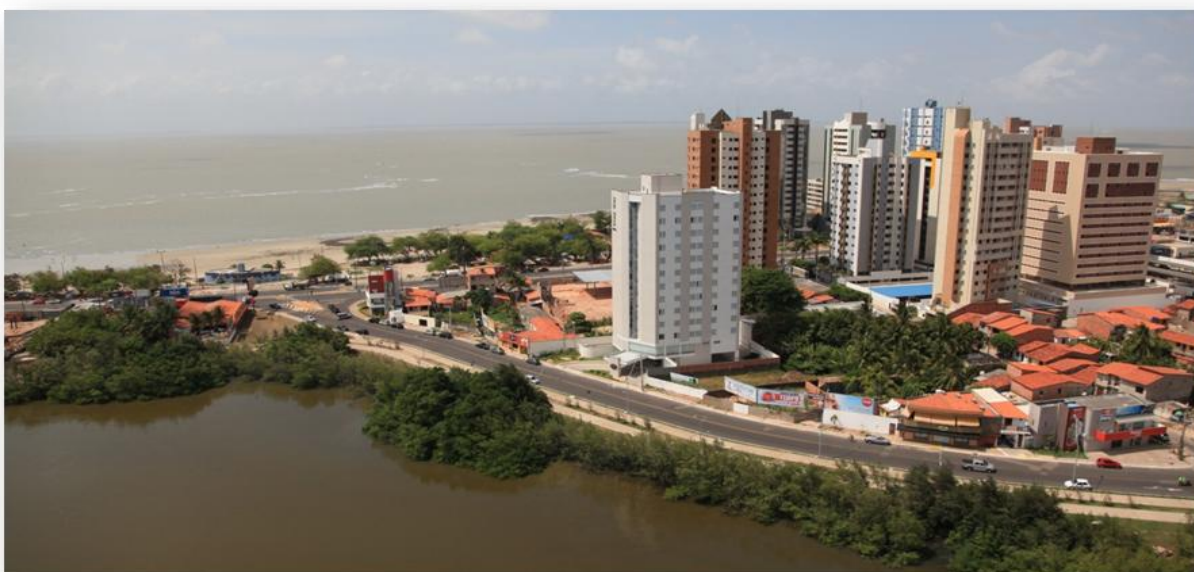
Figura 43. Vista aérea do crescimento verticalizado, na área da Ponta da Areia. 2011. Foto: RIO BRANCO, 2011.
