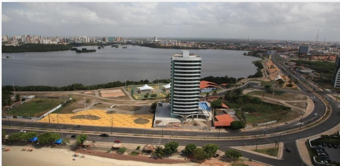
Figura 23. Vista frontal das Avenidas Holandeses e Ana Jansen. 2011. Foto: RIO BRANCO, 2011.
