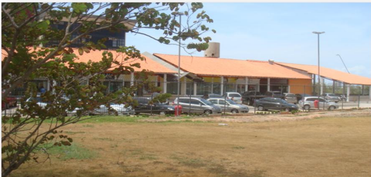
Figura 46. Shopping Atlanta Center, construído sobre área de mangue, na borda da Lagoa da Jansen, conforme demonstra o resquício da vegetação à esquerda. 1996. Foto: RIO BRANCO, 1997.
