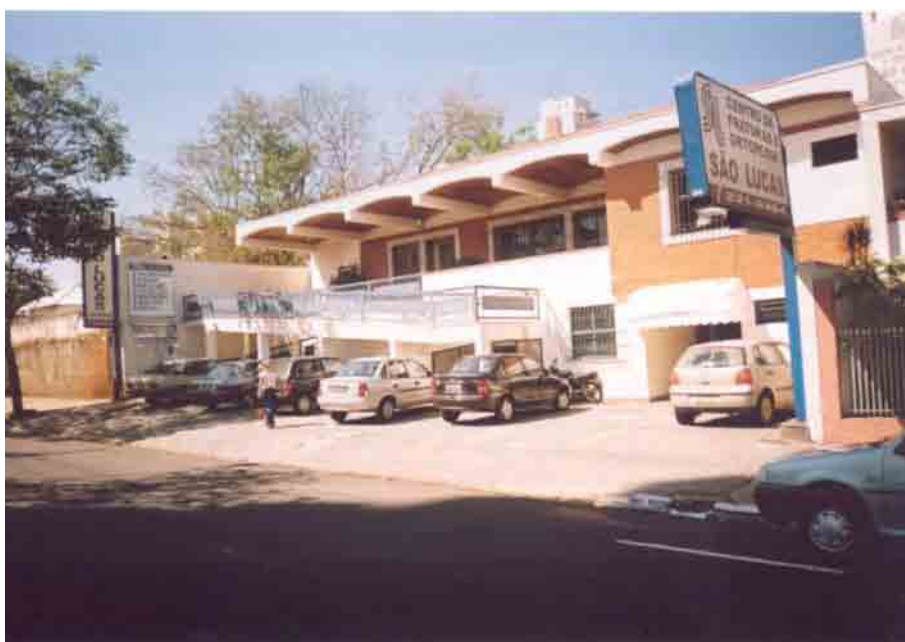
Fotografia 2: Rebaixamento total da guia frente a serviço médico na avenida Washington Luiz (outubro de 2004)
