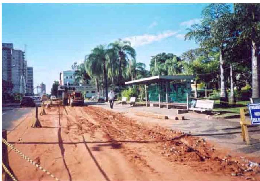
Fotografia 10: Obras na Praça 9 de Julho (junho de 2004)
