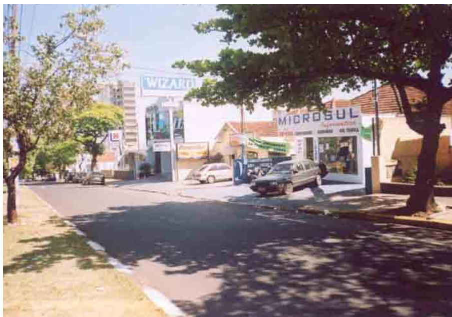
Fotografia 1: Rebaixamento total da guia frente a estabelecimento comercial na avenida Washington Luiz (outubro de 2004)
