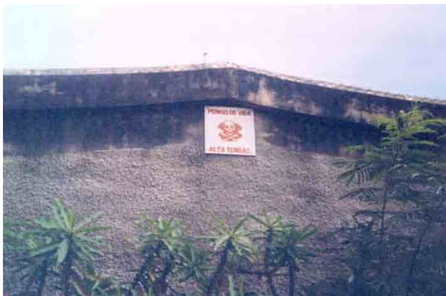
Fotografia 21: Muro do loteamento fechado Jardim João Paulo II (outubro de 1998)
