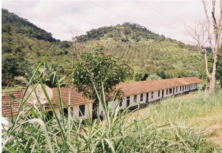
FOTO 7 – O fenômeno da latência fica didaticamente representado pela “colônia” (ou “correr de casas”), criada pela antiga economia do café. Esta forma remanescente do habitat serve atualmente de moradia para duas famílias de trabalhadores permanentes que lidam com a lavoura do chuchu e também para assalariados temporários que chegam de Minas Gerais na época da colheita do caqui. A plantação observada na encosta ao fundo é feita em linha de maior declive. Os interespaços entre as fileiras de caquizeiros são ocupados pelo capim colônia. (Fazenda Boa Vista)
