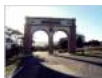
Figura 2 – Pórtico de entrada ao município.
